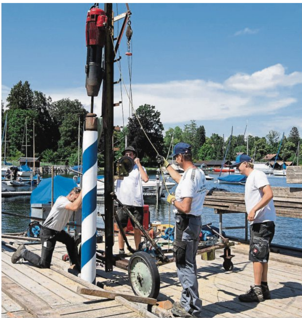
Mit der Gewalt von 100 Kilo hämmert die Ramme, die Jörg Dietrich per Seilzug bedient, den Venezianerpfahl in den Grund des Starnberger Sees. Davor haben die Handwerker den alten morschen Pfahl herausgezogen. Der Schlussakt: Der neue Pfahl bekommt eine gelbe Krone. FOTOS: ANDREA JAKSCH
