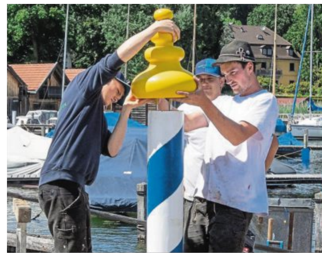
Mit der Gewalt von 100 Kilo hämmert die Ramme, die Jörg Dietrich per Seilzug bedient, den Venezianerpfahl in den Grund des Starnberger Sees. Davor haben die Handwerker den alten morschen Pfahl herausgezogen. Der Schlussakt: Der neue Pfahl bekommt eine gelbe Krone. FOTOS: ANDREA JAKSCH
